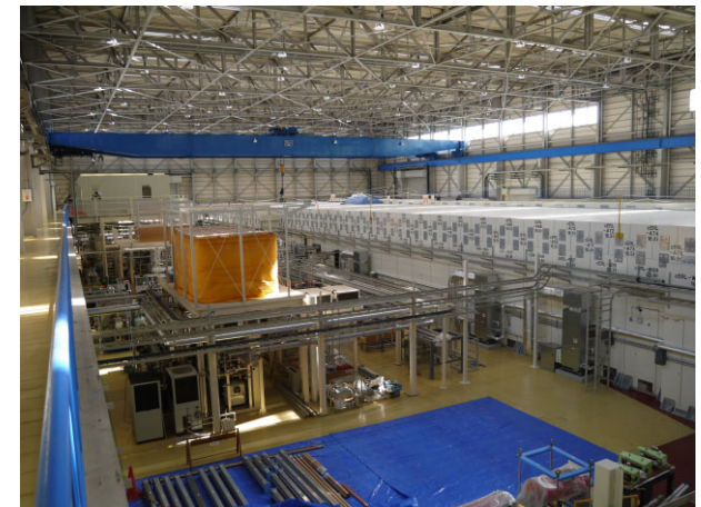
図3 建設されたコンパクト ERL 加速器室
