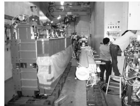
PF リング 2 番直線部 改造作業中
