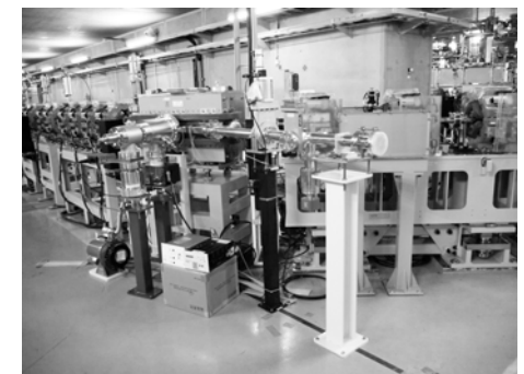
cERL 周回部ビームライン 設置工事完了
